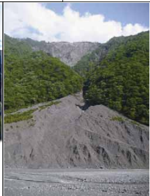
赤崩の斜面崩壊
