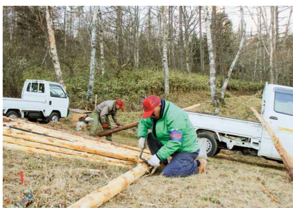
防鹿柵設置作業 (甘利山:甘利山倶楽部)
