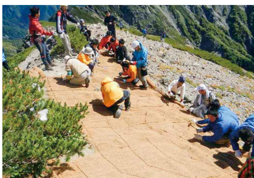
土壌流出防止ヤシ殻マットの敷設 (塩見岳)
